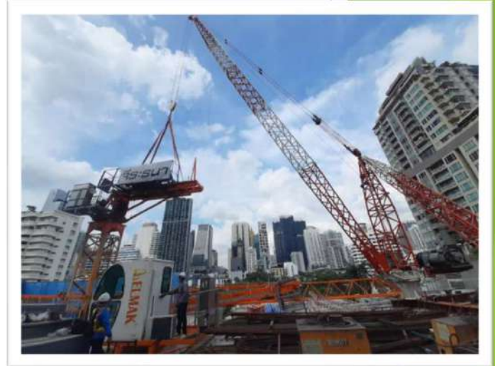
รื้อถอนทาวเวอร์เครนยี่ห้อ ELMAK รุ่น JL66-5 ด้วยเดอริคเครน No.8 น้ำหนักยกสูงสุด 6 ตัน ความยาวแขน 30 เมตร หน่วยงาน : ทาวน์โฮม 531 Fynn Residence H31
