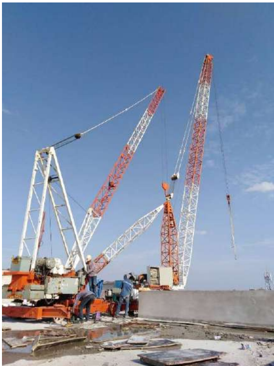
Derrick Crane No.4 360° น้ำหนักยกสูงสุด 2 ตัน ความยาวแขน 20 เมตร หน่วยงาน : พระราม2
