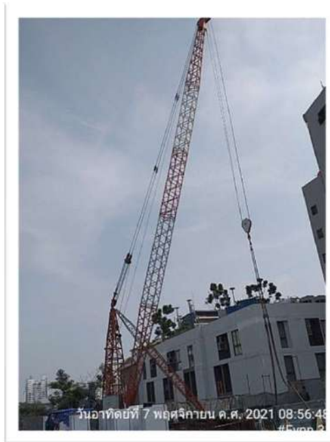
รื้อถอนทาวเวอร์เครนยี่ห้อ ELMAK รุ่น JL66-5 ด้วยเดอริคเครน No.8 น้ำหนักยกสูงสุด 6 ตัน ความยาวแขน 30 เมตร หน่วยงาน : ทาวน์โฮม 531 Fynn Residence H31
